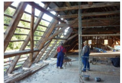
Bau Kindergarten Niedergräfenhain 2012
