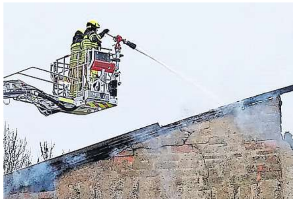
Mithilfe der Bornaer Drehleiter haben die Feuerwehrleute von oben den Stall- und Scheunenbrand bekämpft.
