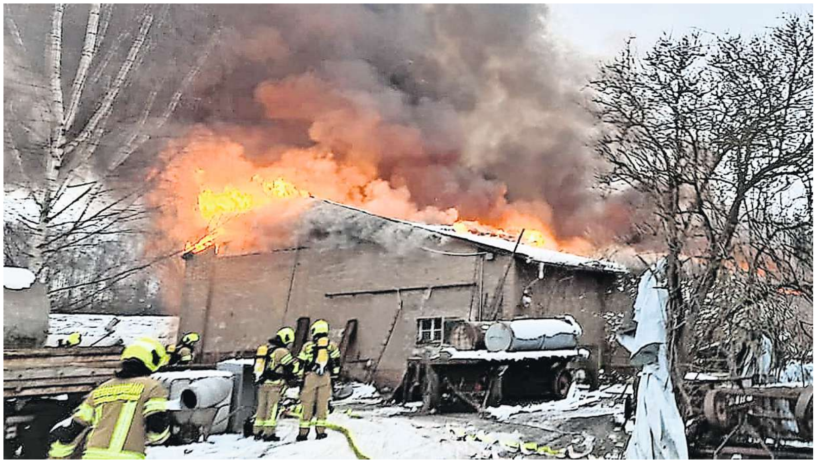
Trotz des Einsatzes der Feuerwehrleute ist beim Stall- und Scheunenbrand in Wildenhain das Gebäude nicht mehr zu retten. Aufgrund der Flammen und Rauchgase kommen wohl etwa 20 Kühe um.
